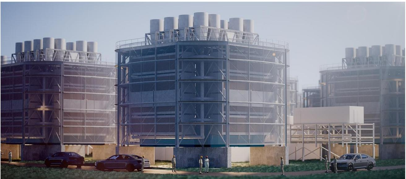
*Die DAC-Technologie Generation 3 basiert auf neuartig strukturierten Sorptionsmitteln in würfelförmigen Modulen.*
