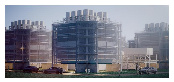
La tecnologia di cattura diretta dall'aria di terza generazione si basa su una nuova struttura dei materiali assorbenti, alloggiati in cubi modulari.
